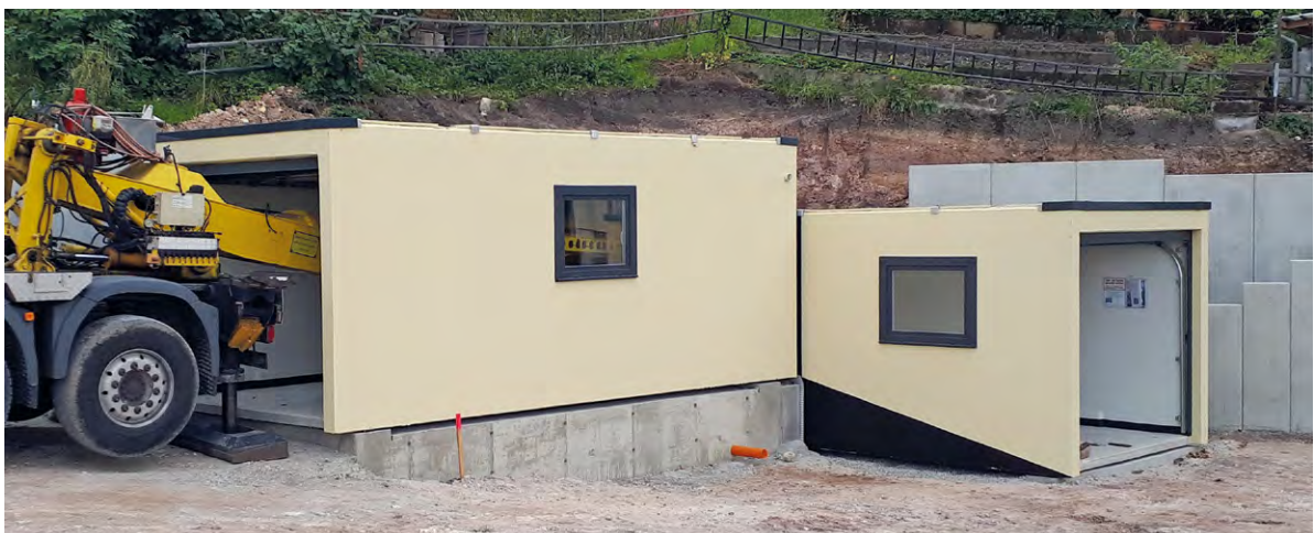
Aufstellen der Prototypen mit Bodenplatte aus Carbon-/Textilbeton im Raum Dresden.
