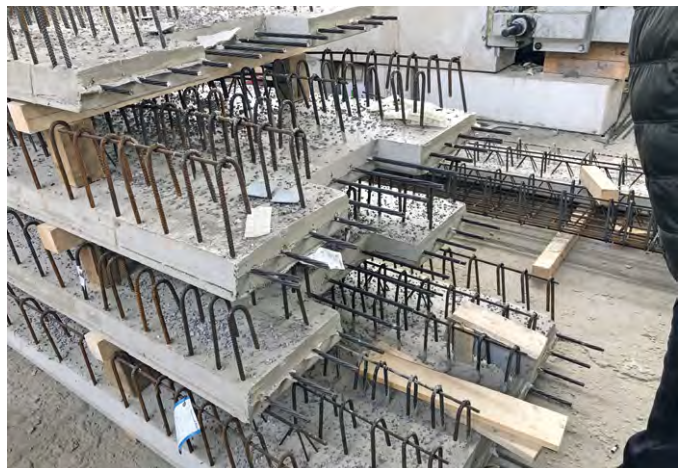
Abb. 5: Spannbettvorspannung für die vorgefertigten Gurtstreifenplatten.
