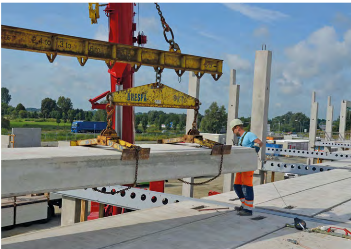
Montage der Spannbeton-Fertigdecken.
