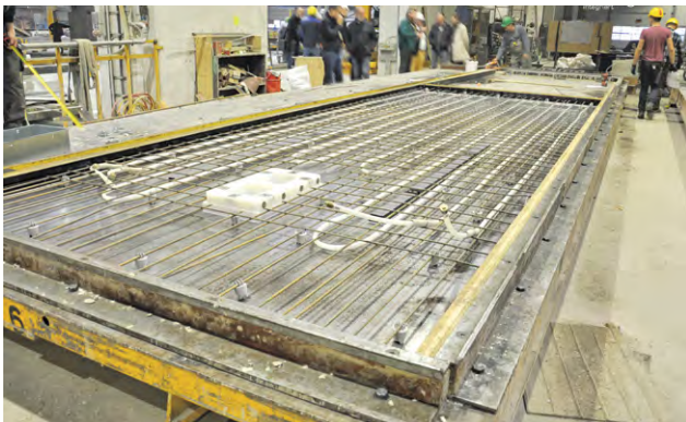
Abb. 6: Herstellung der Deckenelemente mit Rohrregister und Kästen für die Heizverteiler.
