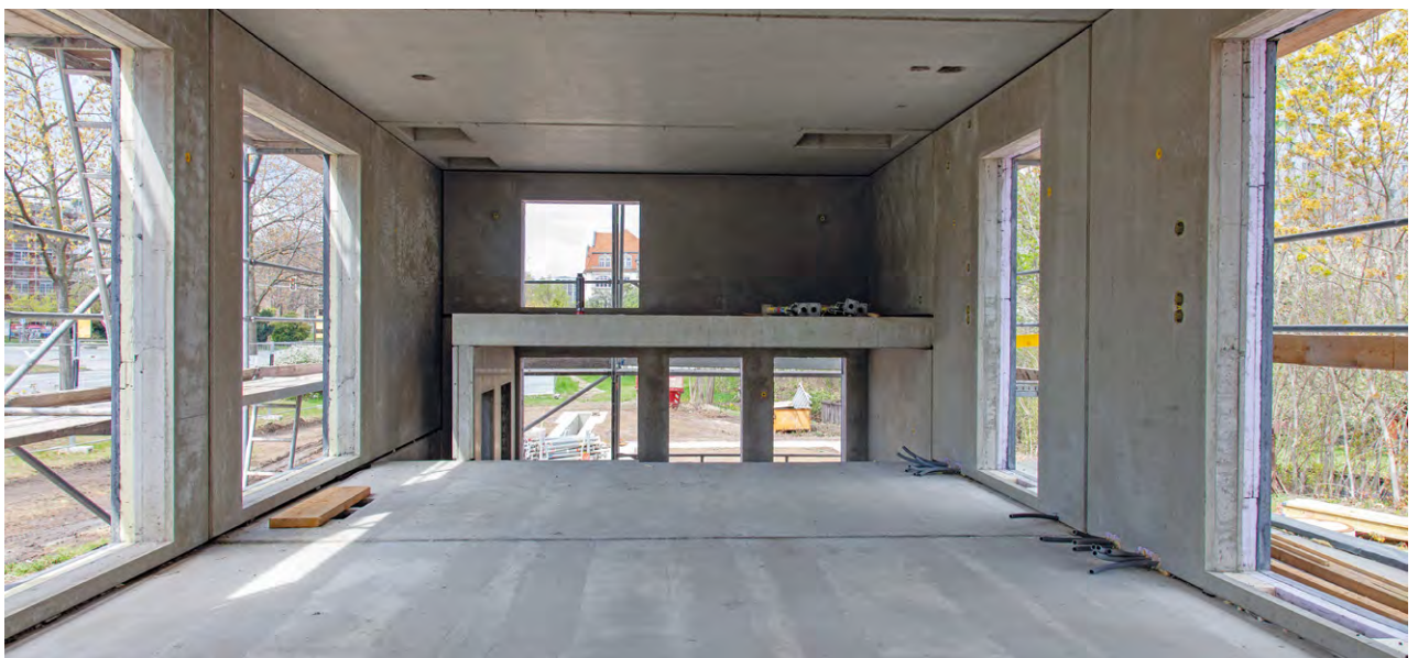
Hier entstehen drei Laborräume. Ansicht der BOX von innen.
