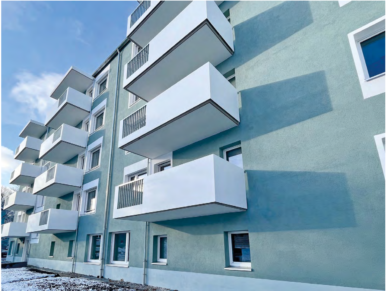
März 2021: Der Rohbau ist komplett.
