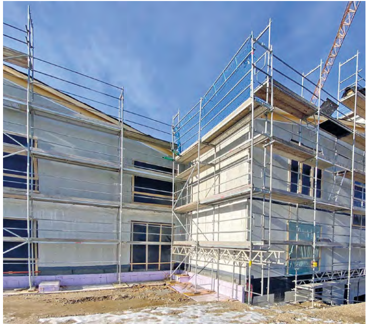
Der komplette Rohbau wurde im März 2021 fertiggestellt.
