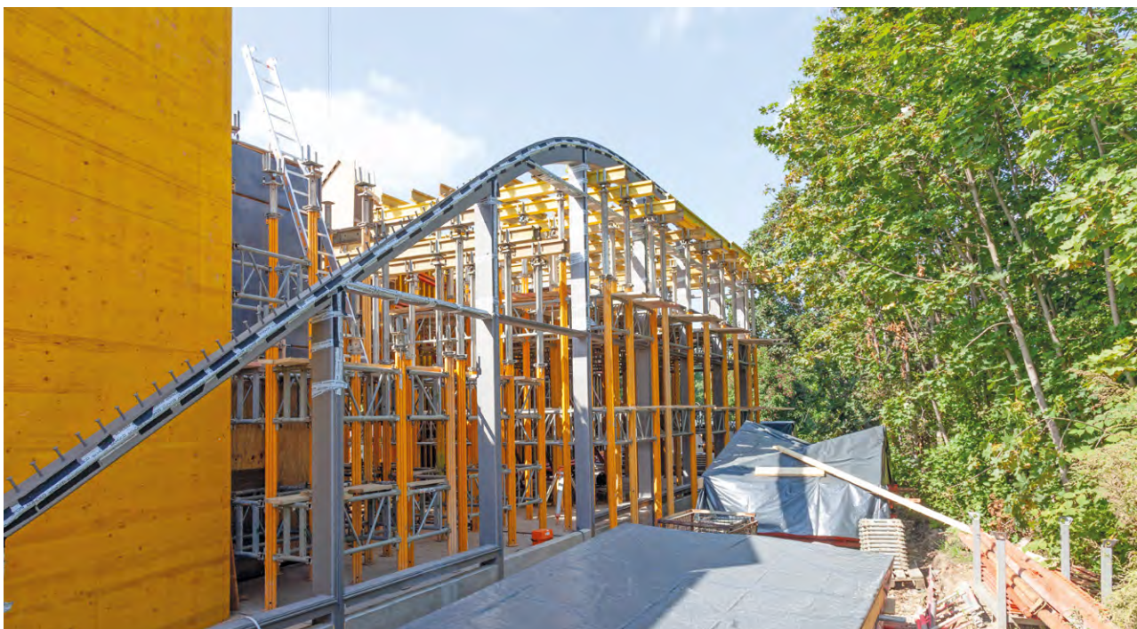
Aufbau der TWIST-Schalung.
