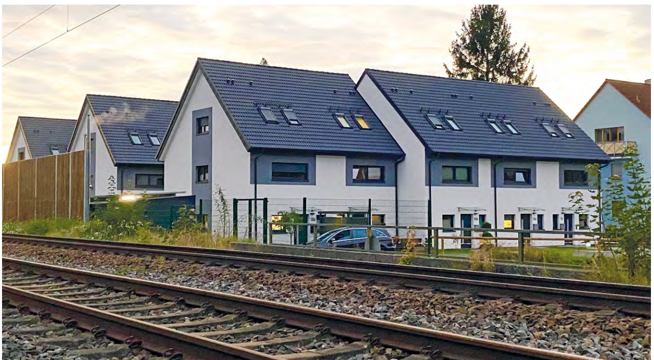
Neue Reihenanlage aus Betonfertigteilen in Nürnberg, Laufamholz entlang der Bahn.
