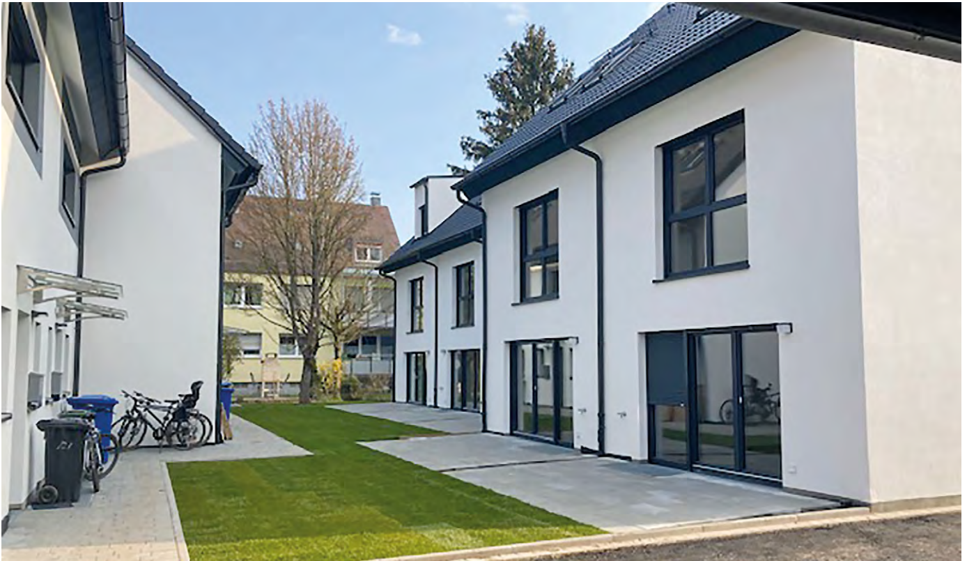
Im Inneren der Reihenhäuser sind die vorbeifahrenden Züge kaum spürbar.
