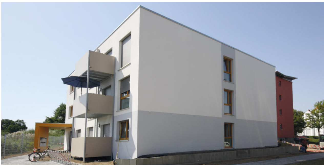
Die vorgefertigten Module wurden nach dem „Lego-Prinzip“ aufeinander gestapelt und miteinander verbunden.
