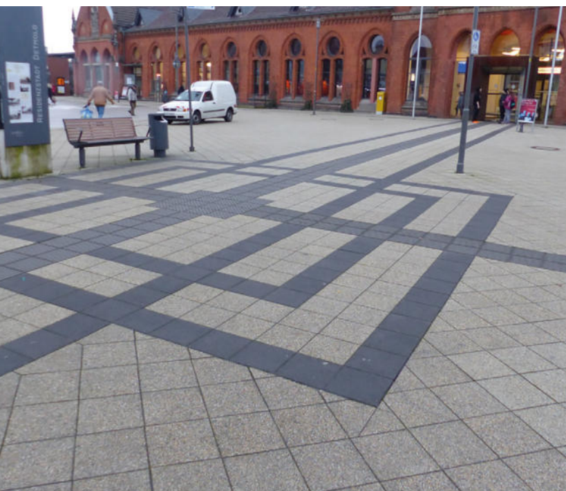
Betonsteine mit TiO 2 -Beimischung (Bahnhofvorplatz Detmold).
