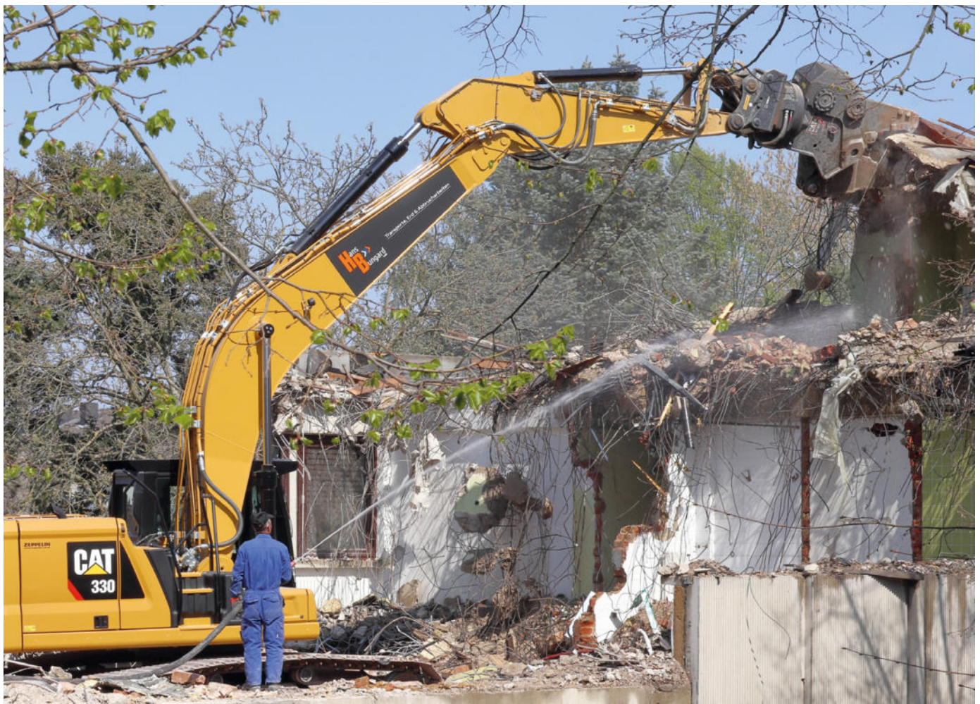
Beim Rückbau konventioneller Gebäude entsteht als Abbruchmaterial ein Konglomerat verschiedenster Materialien.
