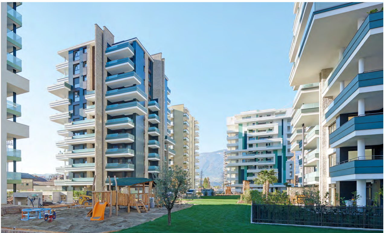
Bei diesem Geschosswohnungsbau in Brixen kamen Thermowände und Klimadecken zum Einsatz. Sie sorgen im Sommer und Winter für ein behagliches Raumklima.
